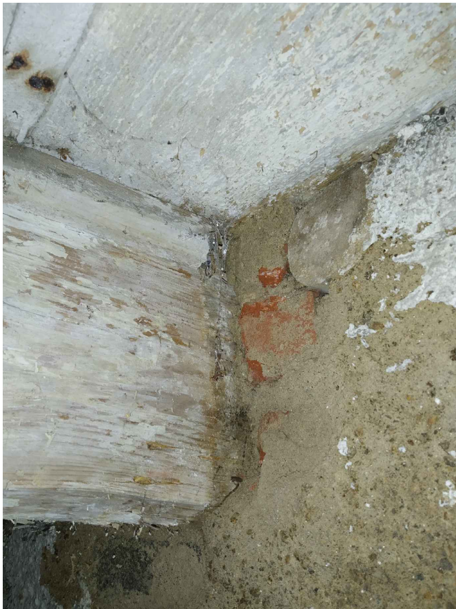
oblast 6 – Poškození hnilobou; vlhkost
