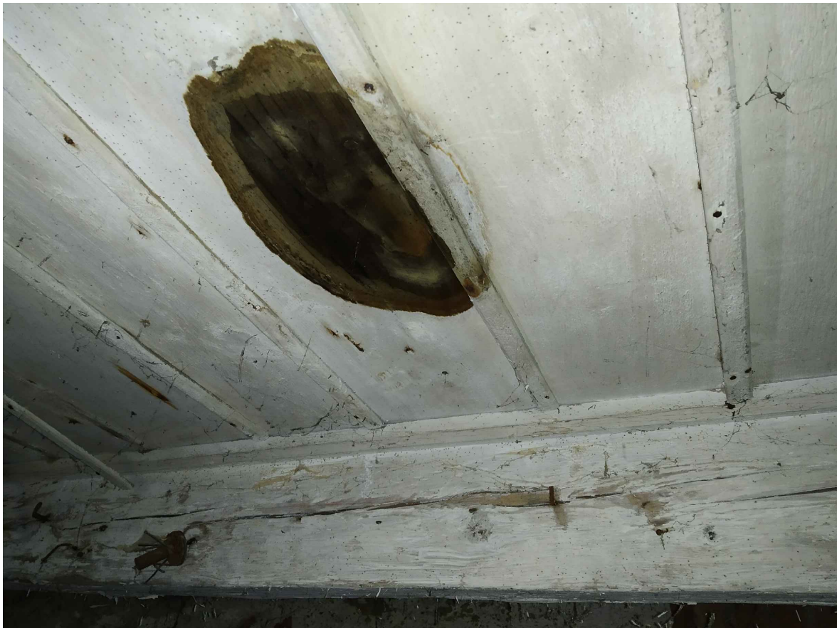
oblast 5 – Poškození dřevokazným hmyzem – viditelné velké množství výletových otvorů; poškození hnilobou; vlhkost
