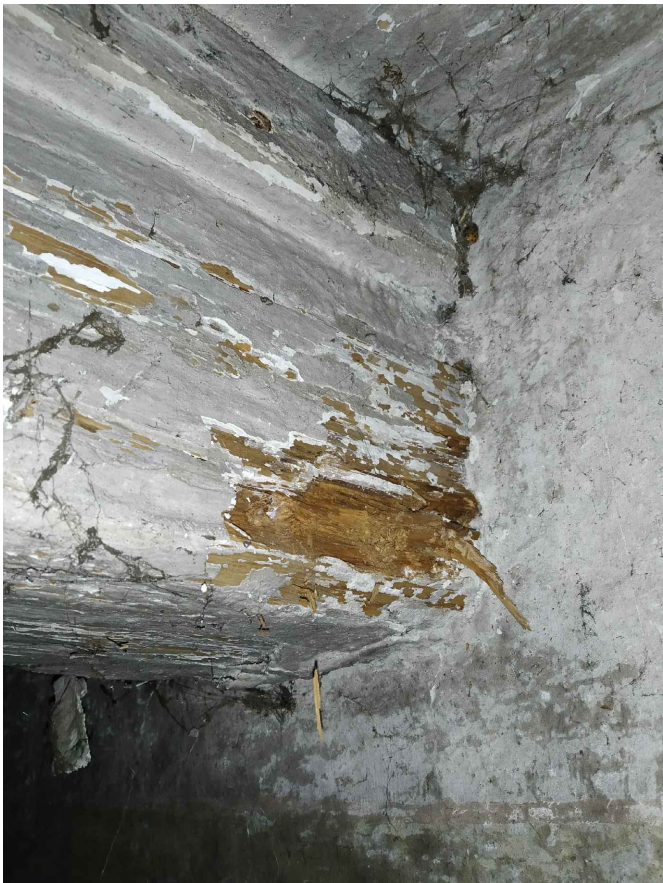
oblast 7 – Poškození hnilobou, vlhkost
