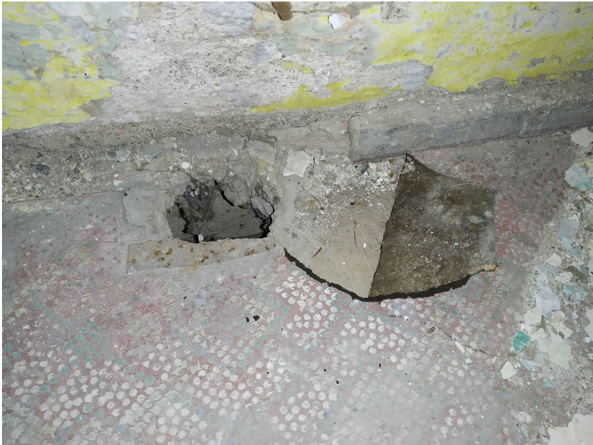
oblast 8 – Poškození hnilobou
